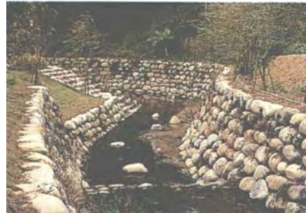
排水溝之生態護岸
