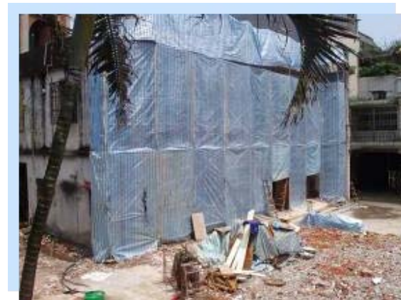
156及157號半拆戶進行牆面修繕、及水電工作
